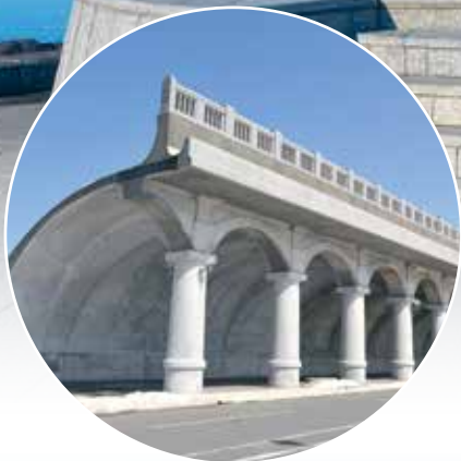
稚内港北防波堤ドーム
